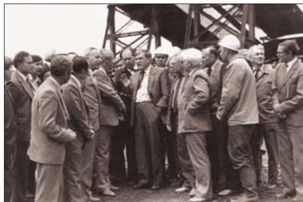
М.И. ЩАДОВ НА СТРОИТЕЛЬСТВЕ ПОГРУЗОЧНОГО КОМПЛЕКСА РАЗРЕЗА ВОСТОЧНЫЙ В ЭКИБАСТУЗЕ, 1985 ГОД
