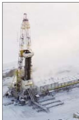
БАНКОРСКОЕ НЕФТЯНОЕ МЕСТОРОЖДЕНИЕ
