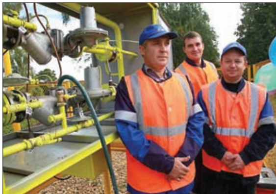
ГАЗОПРОВОД В ДЕР. БОЛОБОНОВО ПИЛЬНИНСКОГО РАЙОНА
