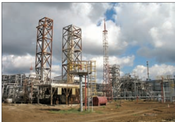
УСТАНОВКА КОМПЛЕКСНОЙ ПОДГОТОВКИ ГАЗА ООО «ДИАЛЛ АЛЬЯНС»
