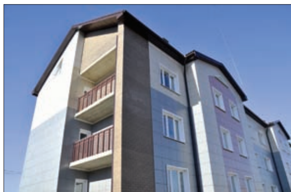
ПЕРВЫЙ В ЛИПЕЦКОЙ ОБЛАСТИ ЭНЕРГОЭФФЕКТИВНЫЙ ДОМ В Г. ГРЯЗИ
