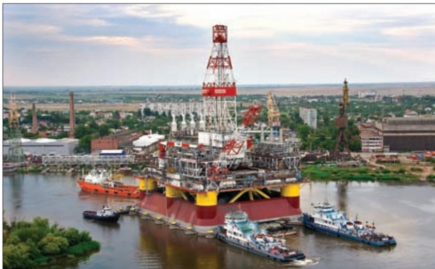
ТРАНСПОРТИРОВКА ЛЕДОСТОЙКОЙ СТАЦИОНАРНОЙ ПЛАТФОРМЫ (ЛСП-1)
