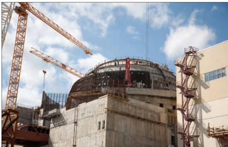
НОВОВОРОНЕЖСКАЯ АЭС-2. РЕАКТОРНОЕ ОТДЕЛЕНИЕ ЭНЕРГОБЛОКА №1
