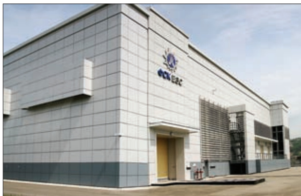
ПС 110 КВ «ЛЕДОВЫЙ ДВОРЕЦ», ФАСАД
