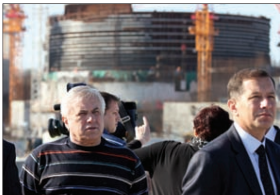
НА СТРОИТЕЛЬНОЙ ПЛОЩАДКЕ ЛЕНИНГРАДСКОЙ АЭС-2
