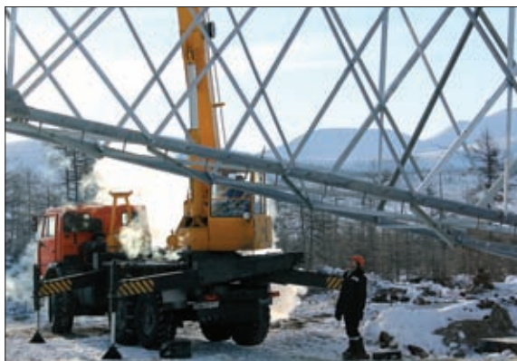
МОНТАЖ ПЕРВОЙ ОПОРЫ ЛИНИИ ЦЕНТРАЛЬНАЯ – СОКОЛ – ПАЛАТКА
