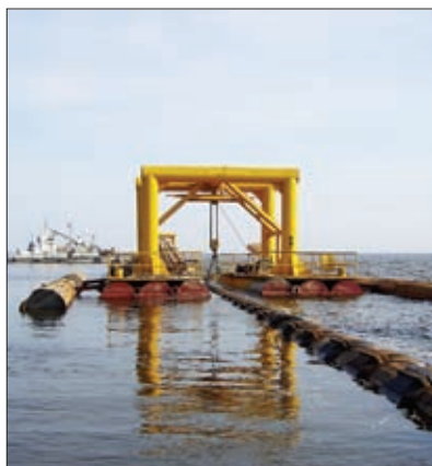
ДЮКЕРНЫЙ ПЕРЕХОД ЧЕРЕЗ ТАЗОВСКУЮ ГУБУ
