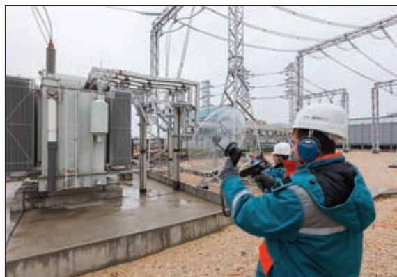
ПРОВЕДЕНИЕ ТЕПЛОВИЗИОННОГО КОНТРОЛЯ И АКУСТИЧЕСКОЙ ДЕФЕКТОСКОПИИ ЭЛЕКТРООБОРУДОВАНИЯ
