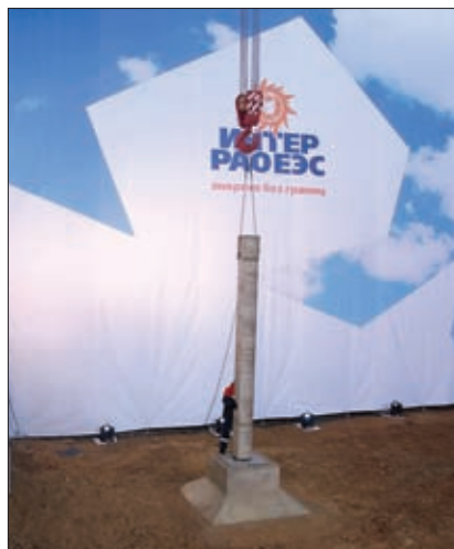
ЗАКЛАДКА ПЕРВОЙ КОЛОННЫ ПОД СТРОИТЕЛЬСТВО ЧЕТВЕРТОГО ЭНЕРГБЛОКА НА ПЕРМСКОЙ ГРЭС
