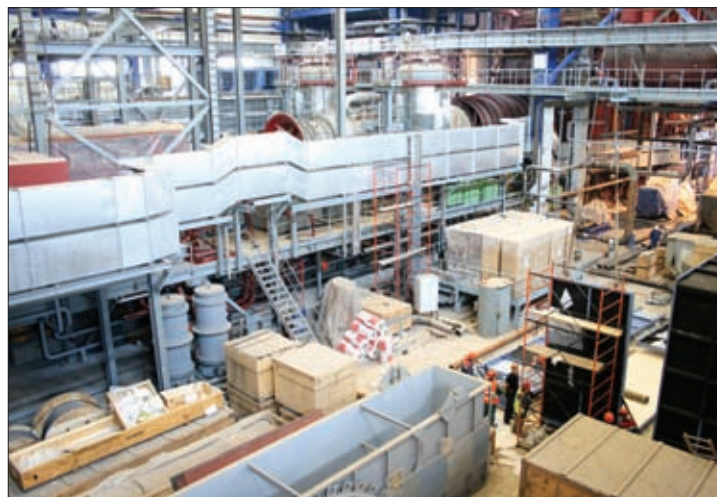
МОНТАЖ ОБОРУДОВАНИЯ НА ПЕРМСКОЙ ТЭЦ-9
