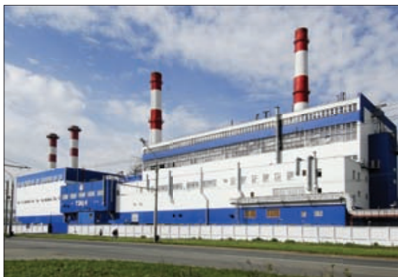
НОВАЯ ПГУ НА ПЕРМСКОЙ ТЭЦ-6 (ВВЕДЕНА В ЭКСПЛУАТАЦИЮ В АВГУСТЕ 2012 ГОДА)
