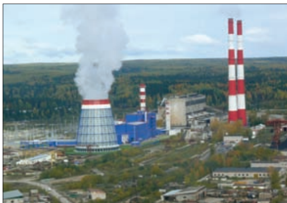
НОВАЯ ПГУ НА ЯЙВИНСКОЙ ГРЭС МОЩНОСТЬЮ 400 МВт (ВВЕДЕНА В ЭКСПЛУАТАЦИЮ В СЕНТЯБРЕ 2011 ГОДА)
