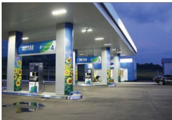
АВТОМОБИЛЬНАЯ ГАЗОНАПОЛНИТЕЛЬНАЯ КОМПРЕССОРНАЯ СТАНЦИЯ
