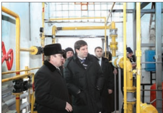
ГУБЕРНАТОР М.В. ЮРЕВИЧ ПОБЫВАЛ В ЗДАНИИ РЕКОНСТРУИРОВАННОЙ КОТЕЛЬНОЙ КУЗНЕЦКОГО СЕЛЬСКОГО ПОСЕЛЕНИЯ АРГАЯШСКОГО РАЙОНА
