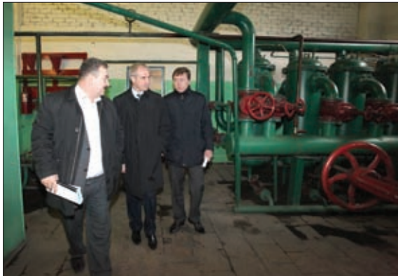
ОСМОТР ПРОИЗВОДСТВЕННЫХ ПОМЕЩЕНИЙ КОТЕЛЬНОЙ
