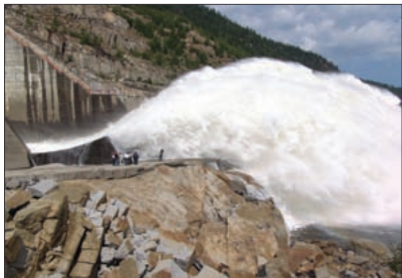
СБРОС ВОДЫ НА КОЛЫМСКОЙ ГЭС
