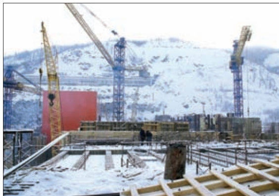
СТРОИТЕЛЬСТВО УСТЬ-СРЕДНЕКАНСКОЙ ГЭС
