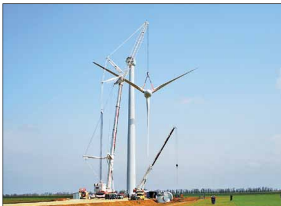
МОНТАЖ ВЭС, С. ПЕСЧАНОЕ, ИЮНЬ 2009 ГОДА
