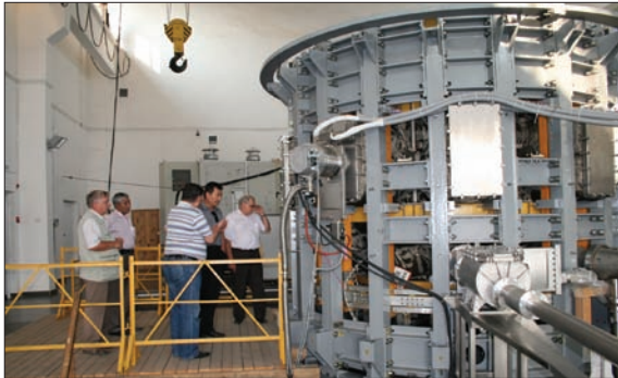
В РЕАКТОРНОМ ПОМЕЩЕНИИ СТРОЯЩЕГОСЯ МАТЕРИАЛОВЕДЧЕСКОГО РЕАКТОРА-ТОКАМАКА КТМ (Г. КУРЧАТОВ)
