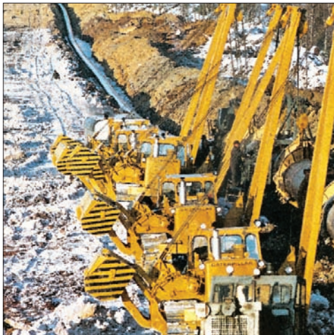
ИЗОЛЯЦИОННО-УКЛАДОЧНАЯ КОЛОННА В РАБОТЕ. ЯМАЛО-НЕНЕЦКИЙ ОКРУГ, 1987 ГОД
