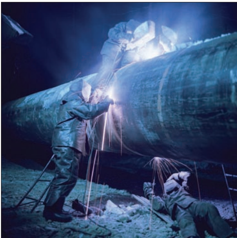
РУЧНАЯ СВАРКА НА ГАЗОПРОВОДЕ УРЕНГОЙ – УЖГОРОД, ЯМАЛО-НЕНЕЦКИЙ ОКРУГ, 1983 ГОД
