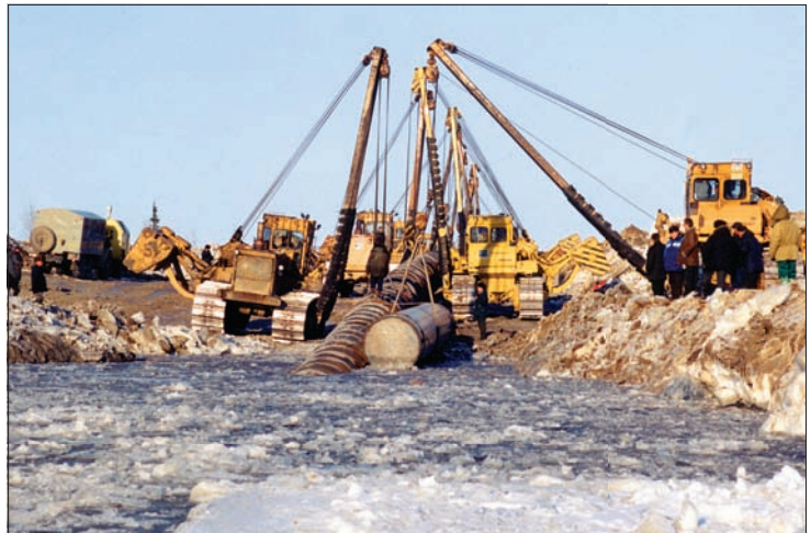
УКЛАДКА ТРУБОПРОВОДА ЧЕРЕЗ Р. ВОЛГУ, 1984 ГОД
