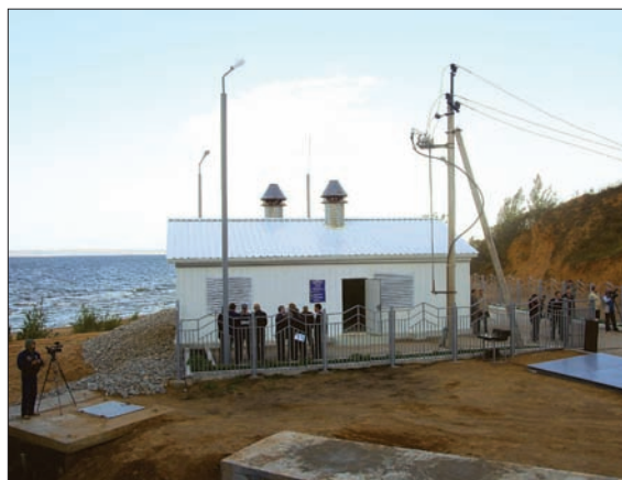
ОДНИМ ИЗ ПЕРВЫХ ПРОЕКТОВ, РЕАЛИЗОВАННЫХ УЛЬЯНОВСКИМ ТЕХНОПАРКОМ, ЯВЛЯЕТСЯ ПРОЕКТ ПО СОЗДАНИЮ МАЛОЙ ГЭС
