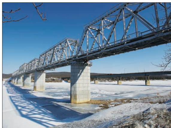
ЖЕЛЕЗНОДОРОЖНЫЙ МОСТ ЧЕРЕЗ Р. АЛДАН У Г. ТОММОТ
