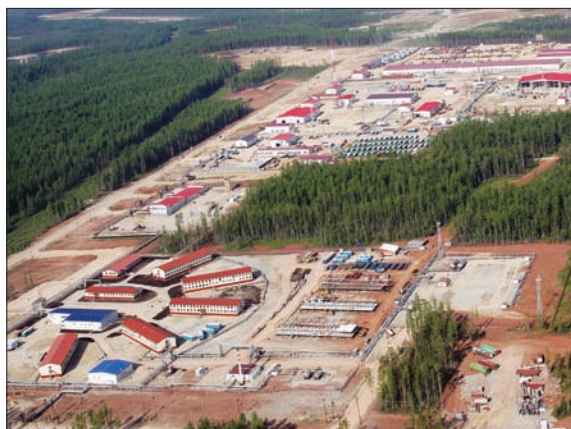
ПОСЕЛОК ВАХТОВИКОВ. ТАЛАКАНСКОЕ МЕСТОРОЖДЕНИЕ НЕФТИ
