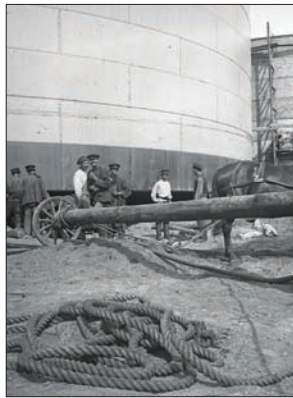
МОНТАЖ НЕФТЯНЫХ РЕЗЕРВУАРОВ КОНСТРУКЦИИ В.Г. ШУХОВА
