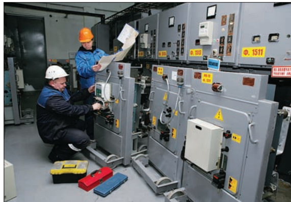
МОНТАЖ ВАКУУМНЫХ ВЫКЛЮЧАТЕЛЕЙ НА ПОДСТАНЦИИ «ФРУНЗЕНСКАЯ»
