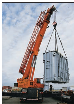
ДОСТАВКА ТРАНСФОРМАТОРА НА ПОДСТАНЦИЮ «ЛЕВОБЕРЕЖНАЯ»
