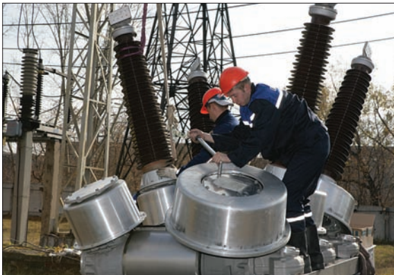
МОНТАЖ ЭЛЕГАЗОВОГО ВЫКЛЮЧАТЕЛЯ
