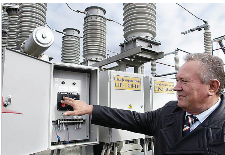
Н.К. МАКСЮТА НА ПУСКЕ ТРАНСФОРМАТОРНОЙ ПОДСТАНЦИИ «ЛЕСНАЯ» 22 ИЮНЯ 2009 ГОДА
