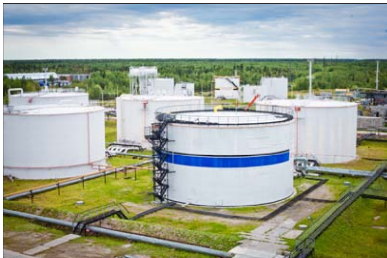
РЕЗЕРВУАРНЫЙ ПАРК СТРЕЖЕВСКОГО НПЗ
