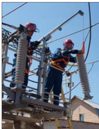
«МОЭСК» – РЕКОНСТРУКЦИЯ ТРАНСФОРМАТОРНОЙ ПОДСТАНЦИИ
