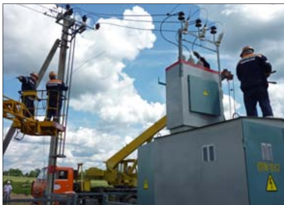
«МОСОБЛЭНЕРГО» – РЕКОНСТРУКЦИЯ ТРАНСФОРМАТОРНОЙ ПОДСТАНЦИИ
