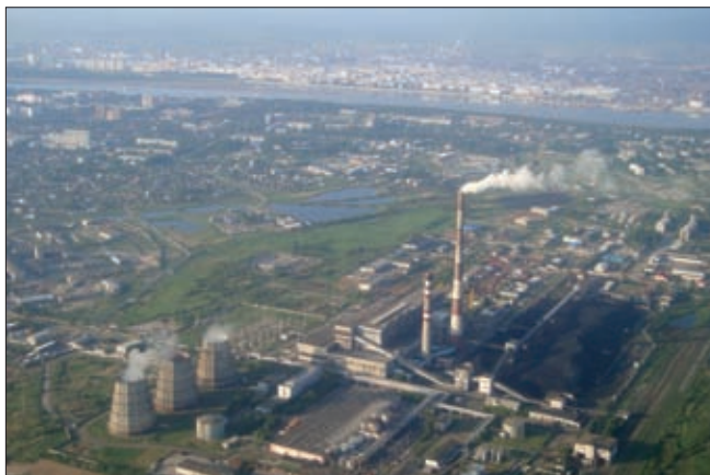
БЛАГОВЕЩЕНСКАЯ ТЭЦ (ВИД СВЕРХУ)
