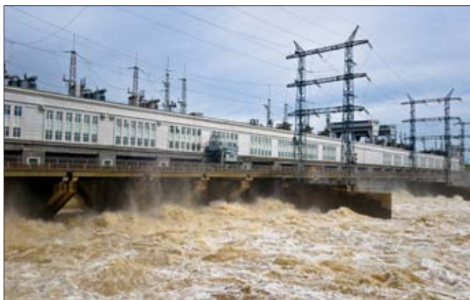
КАМСКАЯ ГЭС ЕЖЕСУТОЧНО ПОКРЫВАЕТ МАКСИМУМ НАГРУЗКИ ЭНЕРГОСИСТЕМЫ ЗАПАДНОГО УРАЛА
