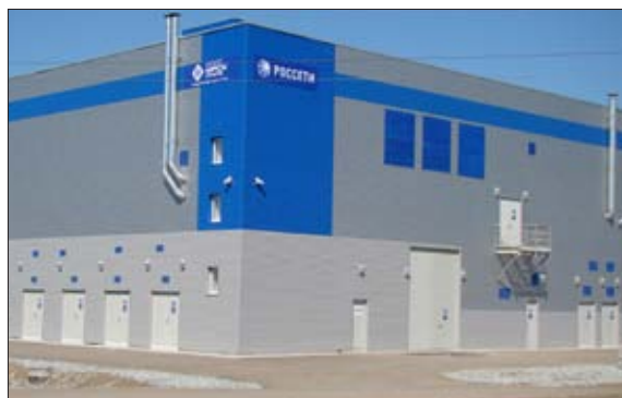
ПОДСТАНЦИЯ «ЗАОСТРОВКА» ВЫДАЕТ ДОПОЛНИТЕЛЬНУЮ МОЩНОСТЬ ДЛЯ ПЕРМСКОЙ ТЭЦ-9 И ПОСТАВЛЯЕТ ЭЛЕКТРОЭНЕРГИЮ ПОТРЕБИТЕЛЯМ ДЗЕРЖИНСКОГО РАЙОНА Г. ПЕРМИ
