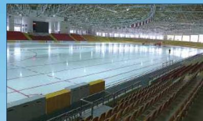
Впервые у плиты, в зоне расположения беговых дорожек, нет ни одного поперечного шва, так как она выполнена из бетона на напрягающем цементе. Например, каток в г. Нагано (Япония) имеет несколько швов, а каждый шов поперек дорожки – это место изменения температуры льда и вследствие этого мгновенной перебивки ритма бега.
