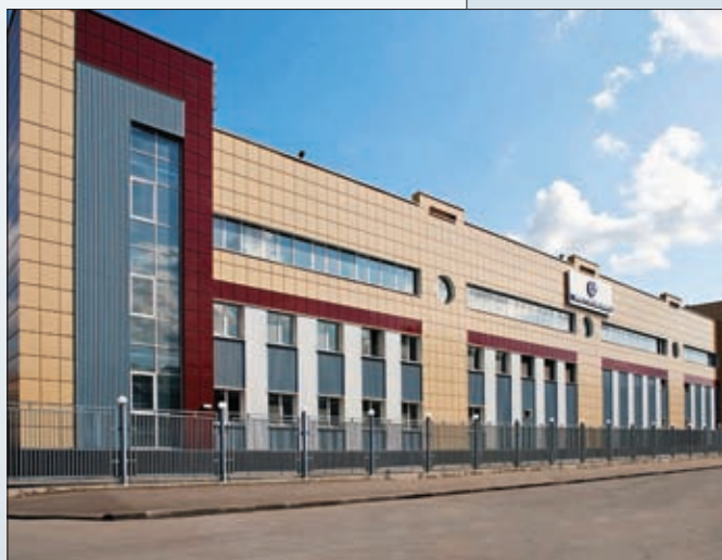
ВЫСОКОВОЛЬТНАЯ Понижающая ЭЛЕКТРОПОДСТАНЦИЯ 220/20 кВ «КРАСНОСЕЛЬСКАЯ»
