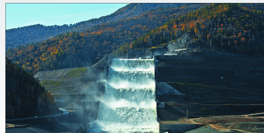
САЯНО-ШУШЕНСКАЯ ГЭС. БЕРЕГОВОЙ ВОДОСБРОС
