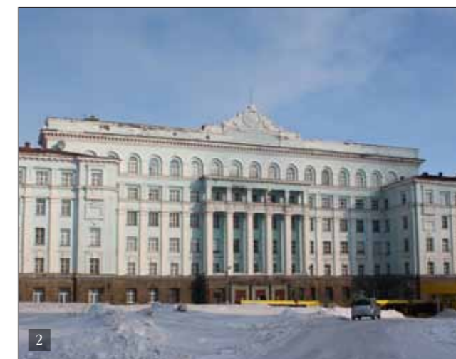
2. ЗДАНИЕ НОРИЛЬСКОГО ИНДУСТРИАЛЬНОГО ИНСТИТУТА
