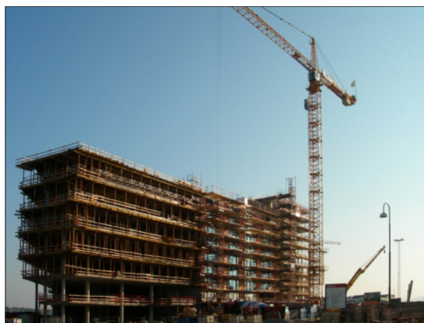
СТРОИТЕЛЬСТВО МНОГОЭТАЖНОГО ДОМА
