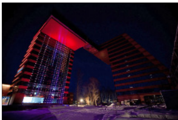
ЦЕНТР КОЛЛЕКТИВНОГО ПОЛЬЗОВАНИЯ И ЦЕНТР ИНФОРМАЦИОННЫХ ТЕХНОЛОГИЙ, ТЕХНОПАРК НОВОСИБИРСКОГО АКАДЕМГОРОДКА
