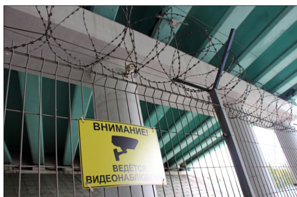
ОГРАЖДЕНИЕ ЗОНЫ ТРАНСПОРТНОЙ БЕЗОПАСНОСТИ
