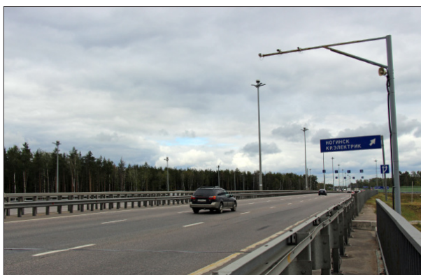
ОПОРА КРЕПЛЕНИЯ ОБОРУДОВАНИЯ СИСТЕМ ВИДЕОНАБЛЮДЕНИЯ, ОПОВЕЩЕНИЯ, ОХРАННОГО ОСВЕЩЕНИЯ
