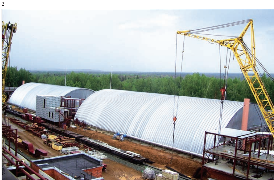
2. Общий вид объекта по уничтожению химического оружия в пос. Горный Саратовской области
