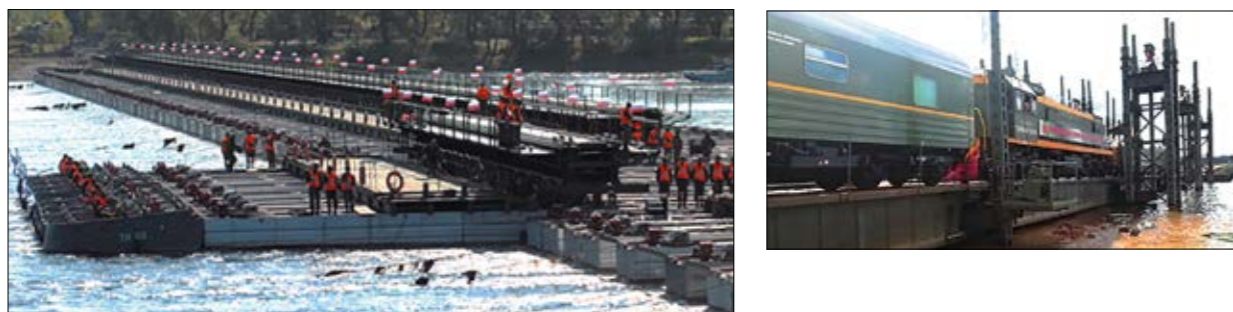
Рис. 10. Фрагменты наплавного железнодорожного моста НЖМ-56 и моста-ленты МЛЖ-ВФ-ВТ.
