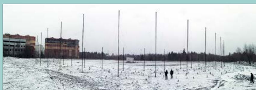
Фото 1. Двухкольцевая фазированная антенная решетка КВ диапазона. На объекте смонтирована двухкольцевая антенная решетка.
