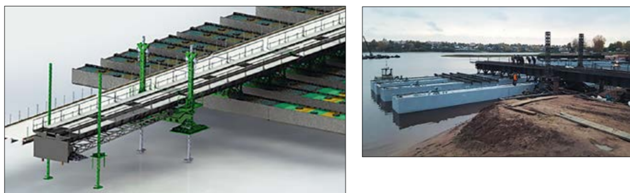
Рис. 11. Фрагмент перспективного наплавного железнодорожного моста НЖМ-2020.
