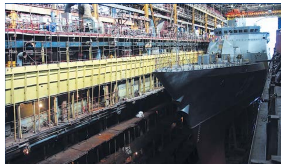
Рисунки 4, 5. Строительство корвета проекта 20380 на АО «Амурский ССЗ».
