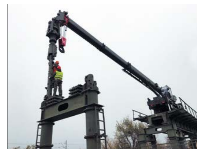
Рис. 9. Установка УЗС-85 производит завинчивание винтовых свай.
