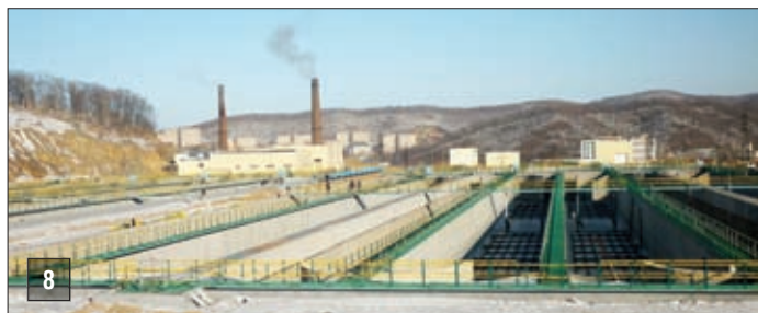
8 Южные очистные сооружения
