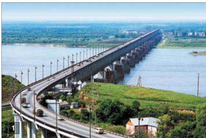
Мост через р. Вах
