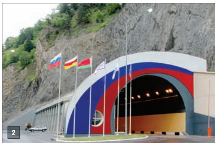
Тоннель на автодороге Алагир – Нижний Зарамаг
