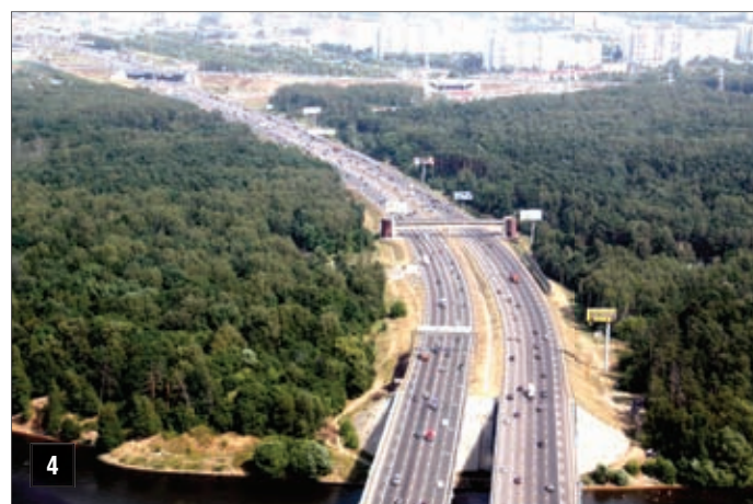
Реконструкция федеральных дорог Московского транспортного узла
