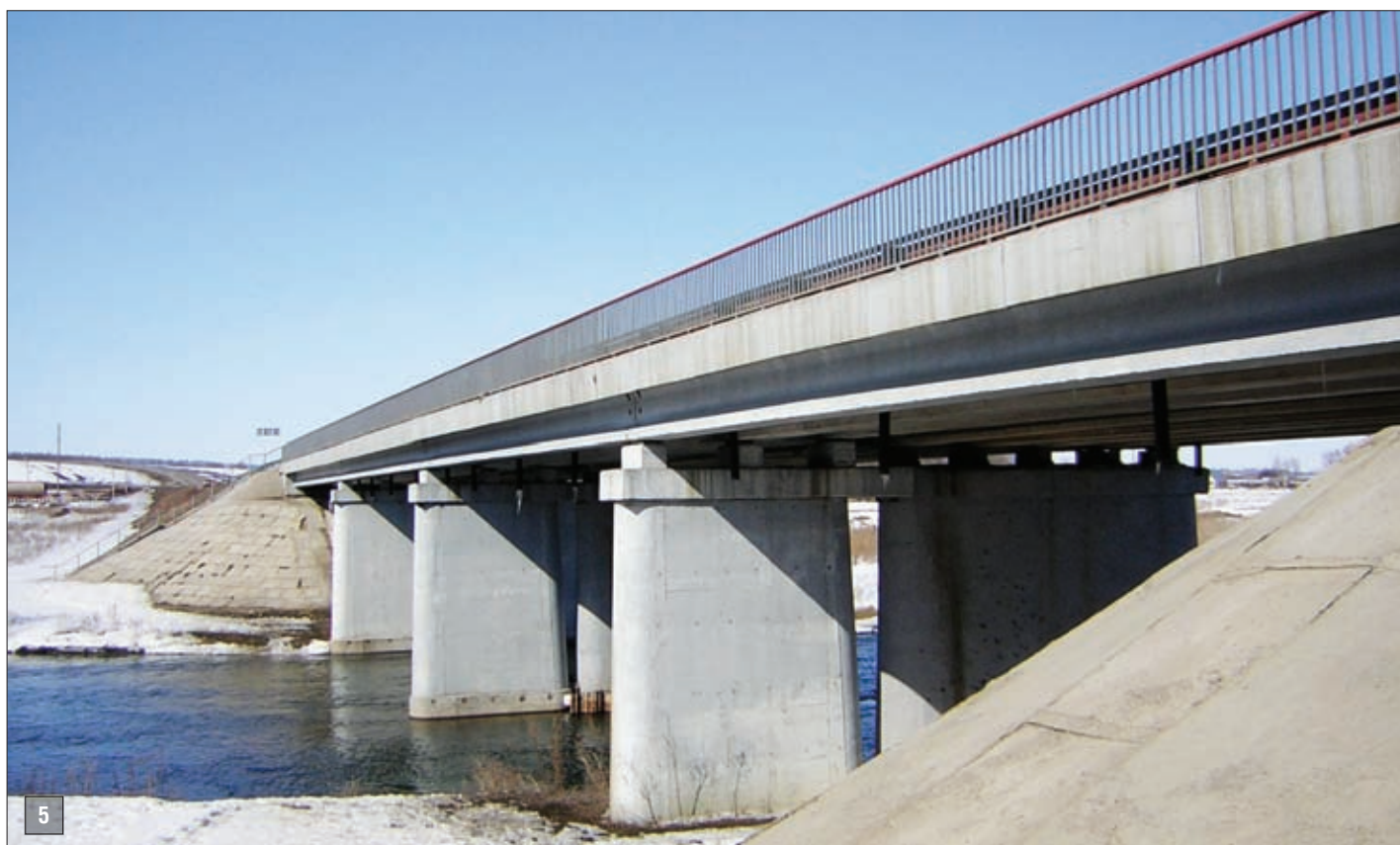
Мост через р. Упу (Тульская область)
