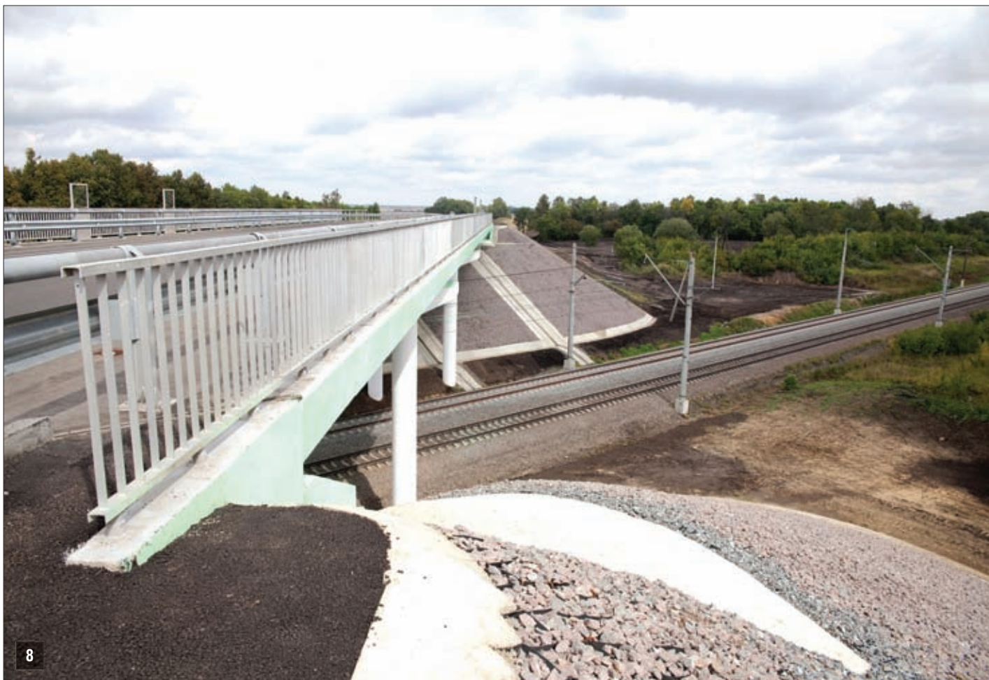
Путепровод на 261-м км М-2 “Крым”
