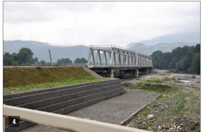
Совмещенная автомобильная и железная дорога Адлер – Альпика-Сервис
