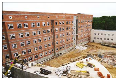
5. Строительство нового корпуса детской областной больницы
