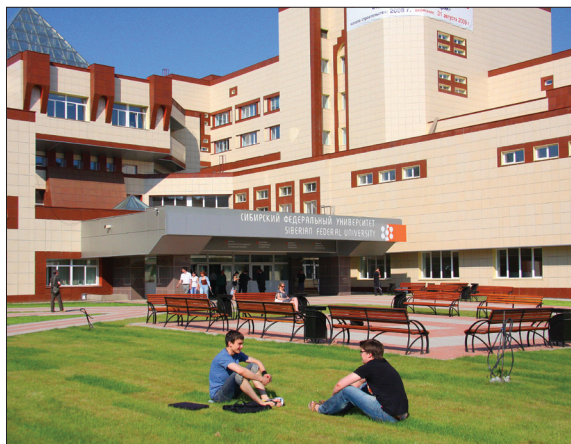
ОДИН ИЗ КОРПУСОВ СИБИРСКОГО ФЕДЕРАЛЬНОГО УНИВЕРСИТЕТА
