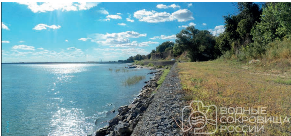
ФОТОГРАФИЯ ПОБЕДИТЕЛЯ В НОМИНАЦИИ «БЕРЕГИ БЕРЕГА!» АВТОРСКОЕ НАЗВАНИЕ: С НОВЫМ БЕРЕГОМ, МОРЕ! АВТОР: ВАЛЕРИЙ ЧАРДЫМОВ МЕСТО ПРОВЕДЕНИЯ СЪЕМКИ: УКРЕПЛЕНИЕ БЕРЕГА ЦИМЛЯНСКОГО ВОДОХРАНИЛИЩА
