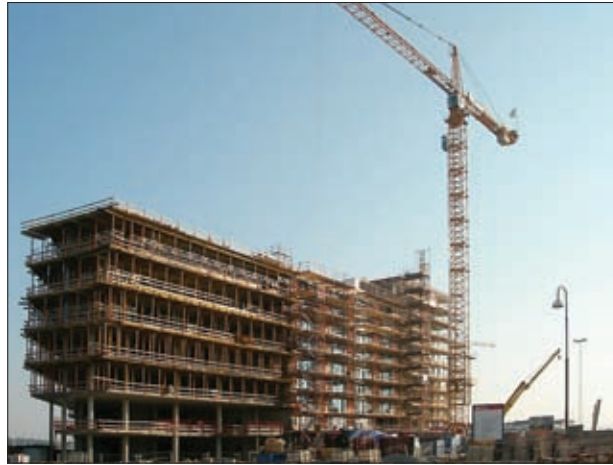
СТРОИТЕЛЬСТВО МНОГОЭТАЖНОГО ДОМА
