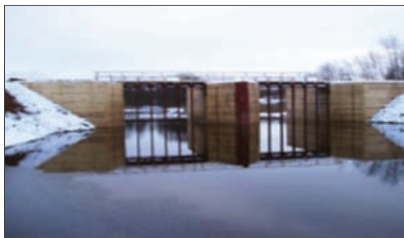
КАПИТАЛЬНЫЙ РЕМОНТ ГЛЕБОВСКОЙ ПЛОТИНЫ НА Р. ИТКЛЕ ВОЛОГОДСКОЙ ОБЛАСТИ
