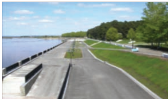
БЕРЕГООУКРЕПЛЕНИЕ ВОТКИНСКОГО ВОДОХРАНИЛИЩА В РАЙОНЕ ПОС. УСТЬ-КАЧКА (II ОЧЕРЕДЬ)
