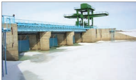
ГИДРОУЗЕЛ СОРОЧИНСКОГО ВОДОХРАНИЛИЩА НА Р. САМАРЕ В ОРЕНБУРГСКОЙ ОБЛАСТИ
