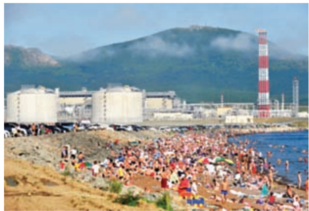
ФАКЕЛЬНАЯ СИСТЕМА ЗАВОДА СПГ, САХАЛИН
